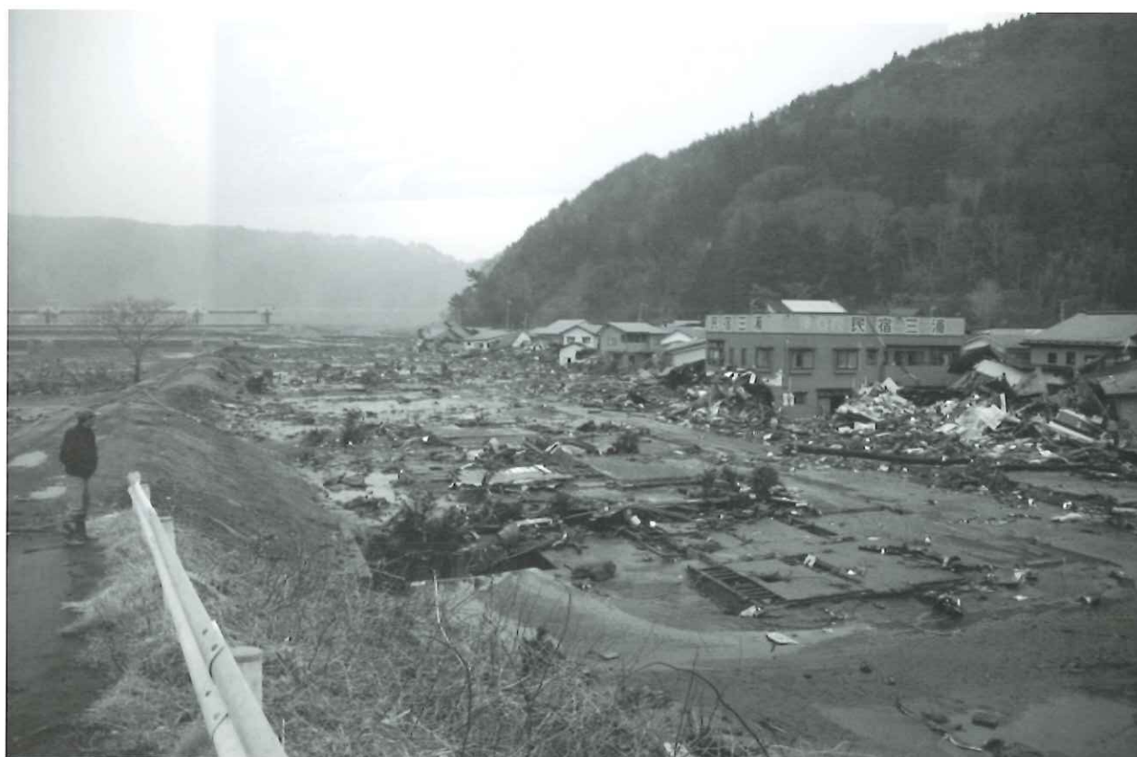
被災した小本地区
