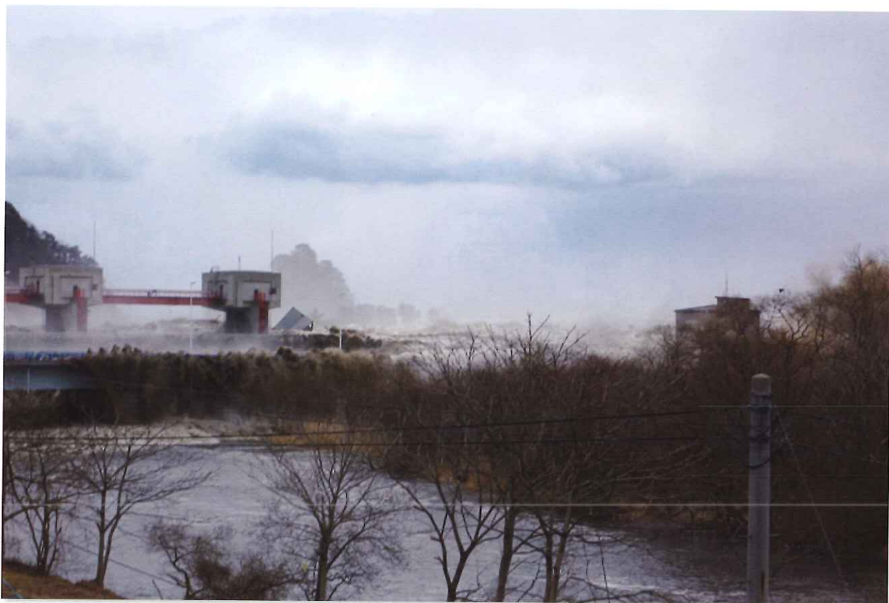
小本港側からも激しい波が襲う。水門の右側には流されてきた建物が見える
