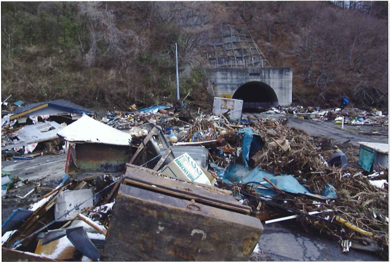
国道 45 号、小成地区
