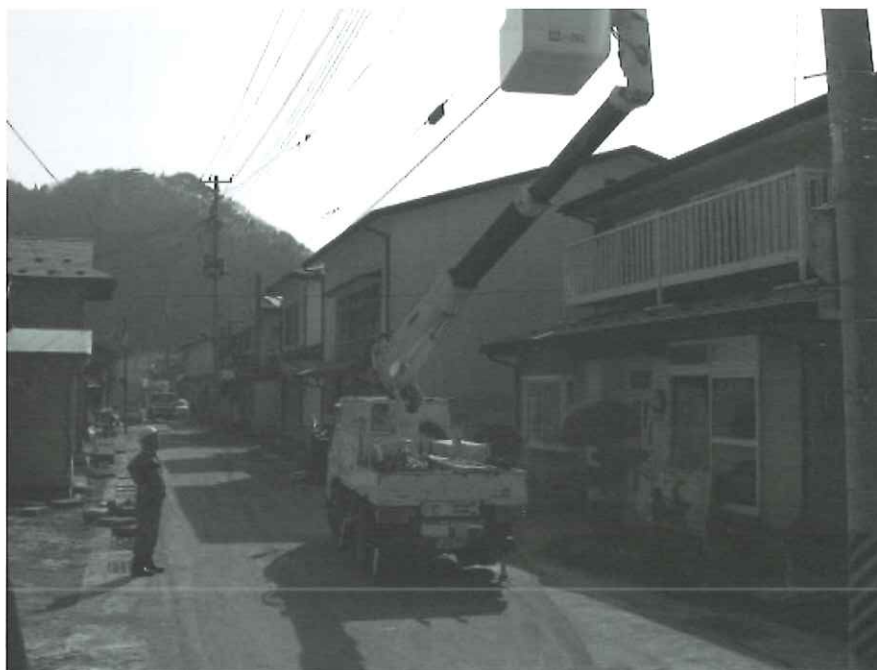
小本地区の電気復旧作業
