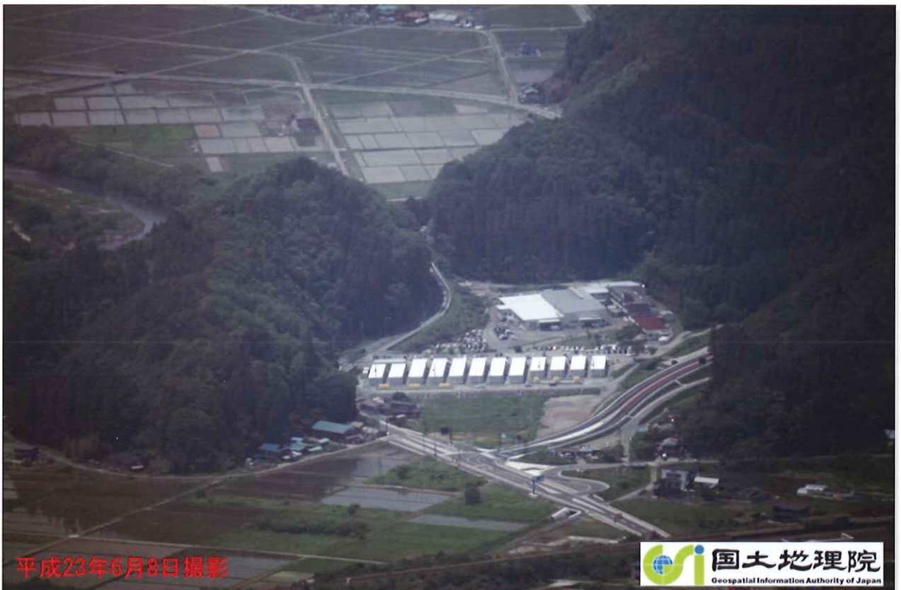
中野バイパス岩泉龍泉洞インター付近に整備された仮設住宅小本団地
