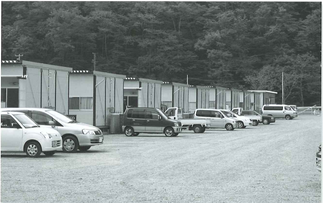
仮設住宅小本団地
