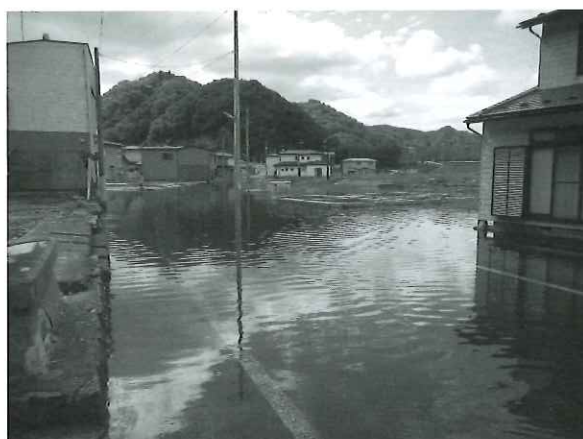
台風で浸水した小本地区
