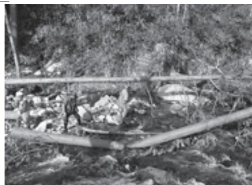
河川流木を撤去する作業員
