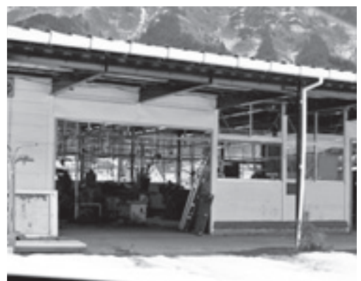
被災した工場
