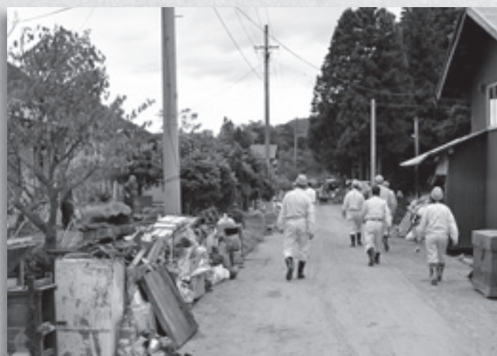
被災状況を調査（巖野地区）
