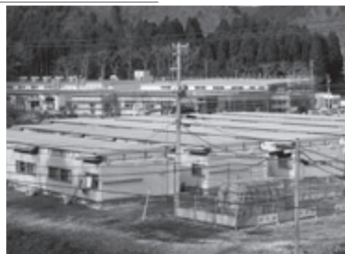
整備され入居希望者が住み替えた仮設住宅
