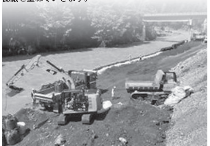
国道455号の早期復旧が望めます（二升石地区）
