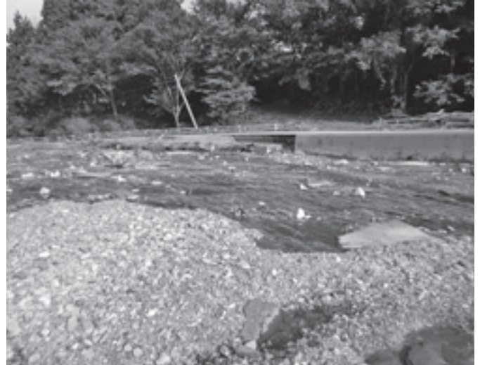
土砂が堆積した農地（震野地区）
