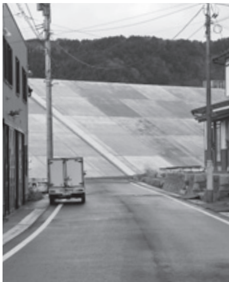
完成した高さ14.7mの山築堤防 (小本字小本)
