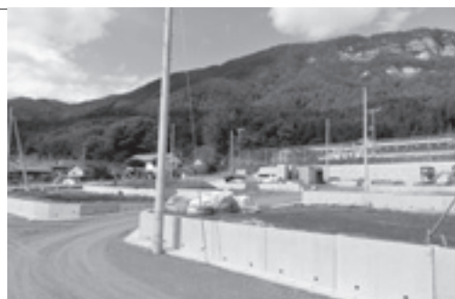
年度内の入居完了を目指し工事が進む 子育て支援住宅団地
