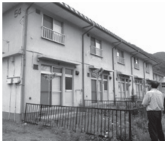
早期改築が望まれる町営住宅大川団地
