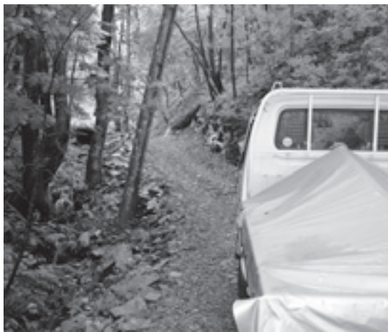
林業振興のためには作業林道が必要です
