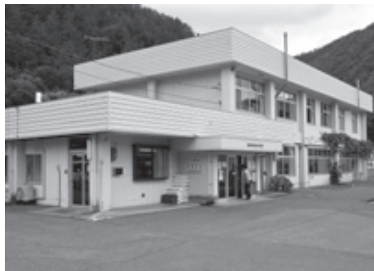
公共施設の再編が待たれる現在の小川支所
