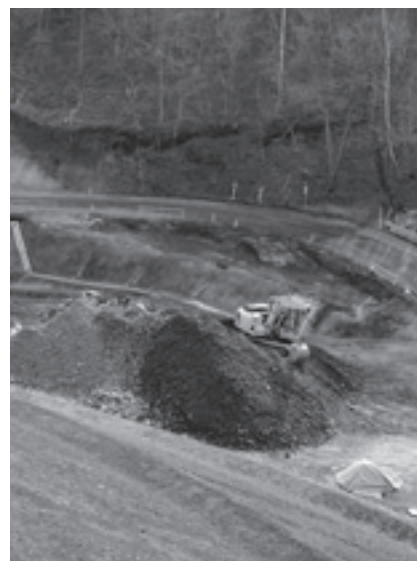
改良工事が進む大月峠
