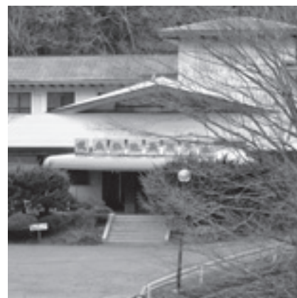
建築されて約40年が経過した龍泉洞温泉ホテル
