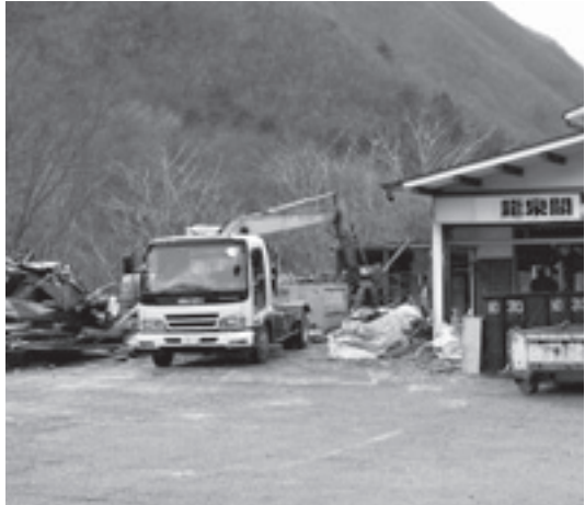
廃屋の除去が進む龍泉洞周辺
