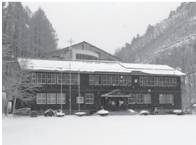
復旧工事を促進するため空き校舎を宿舎として活用すべきです
