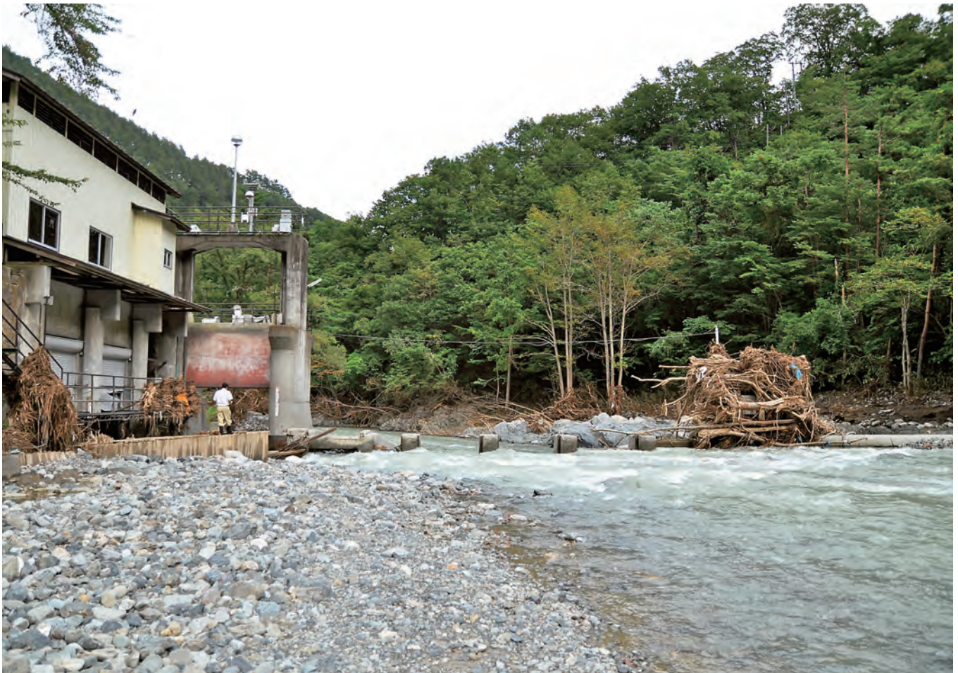
9月19日午後2時28分 東北電力の大川取水口でもがれきがたまっていた
