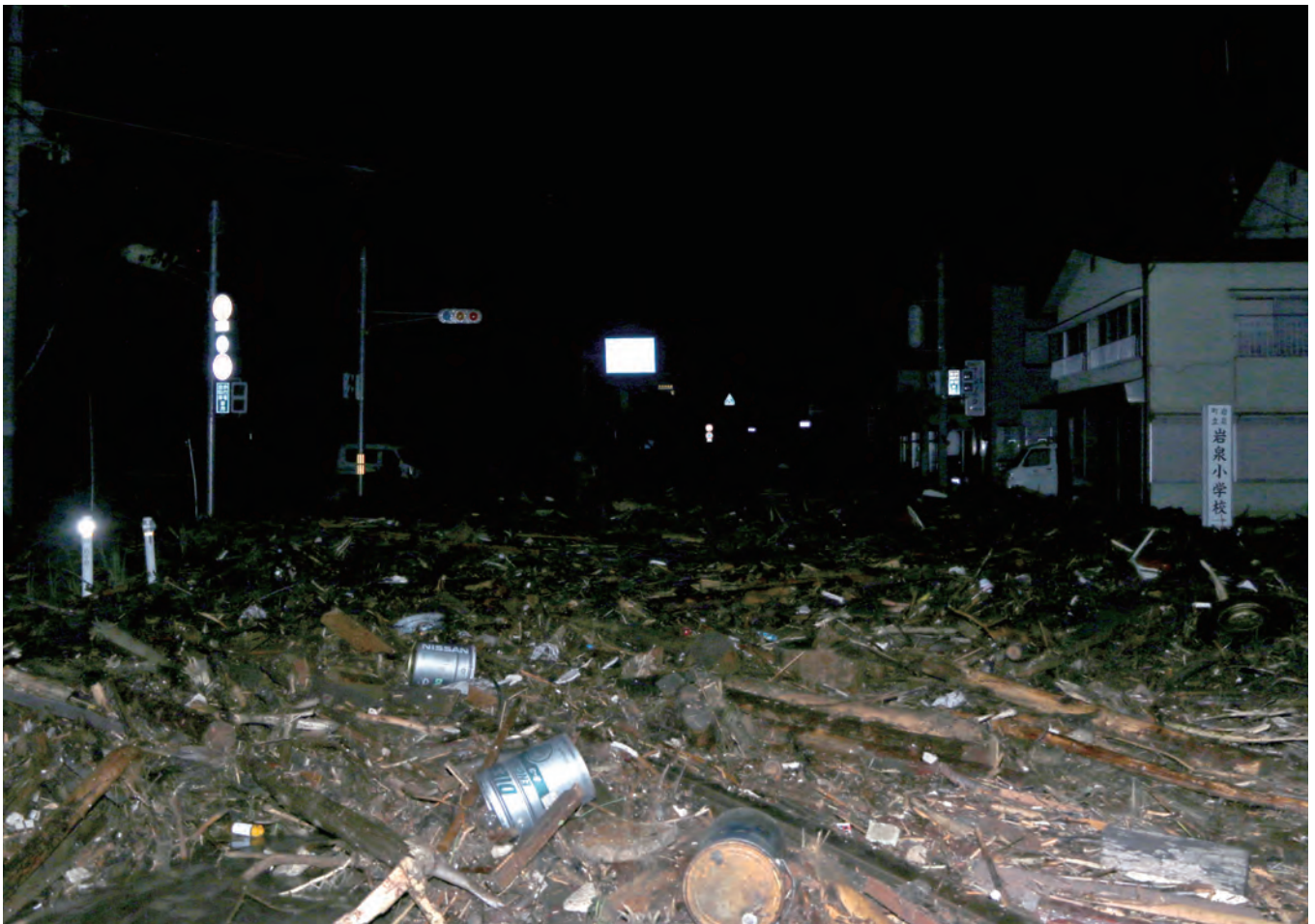
8 月 30 日 午後 9 時 42 分 国道 455 号の岩泉橋付近はがれきの山になった
