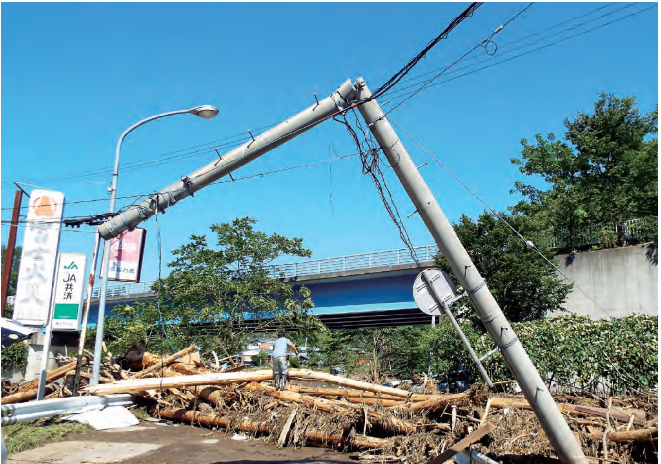
門地区では電柱が折れ曲がり、がれきがたまっていた
