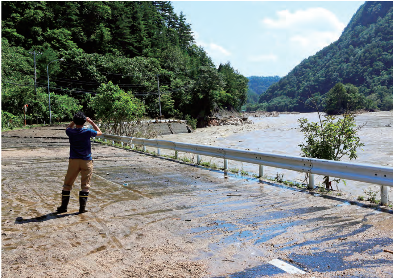
8月31日午後0時15分 乙茂地区へとつながる国道455号は寸断されていた
