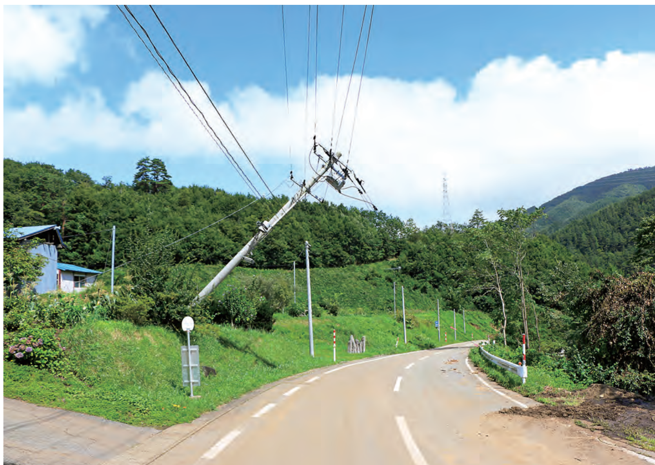
9月3日午前11時57分 下有芸バス停付近では電柱が傾いていた
