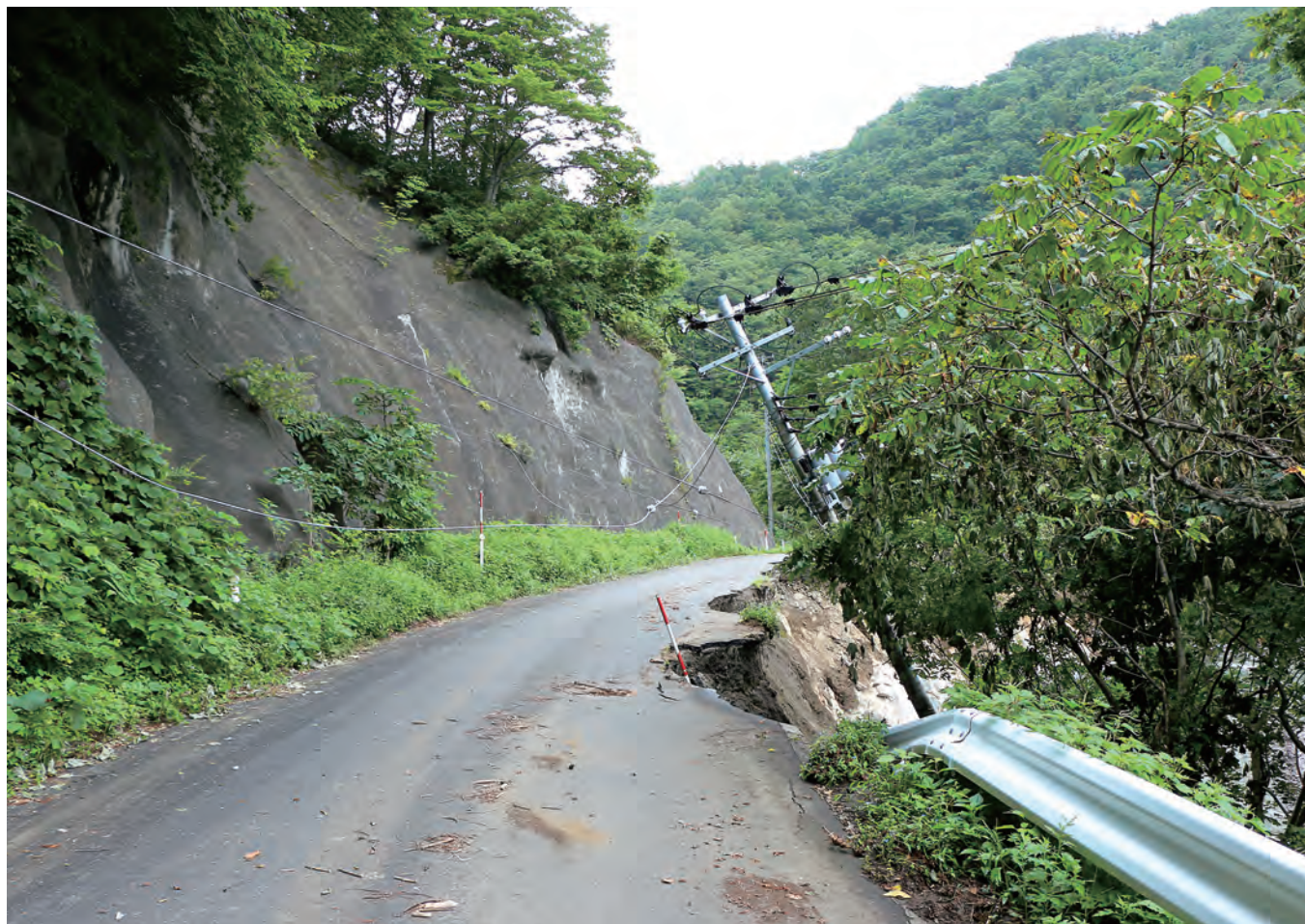
9月3日午前9時48分 肘葛では道路が崩れ、電柱が倒れそうになっていた
