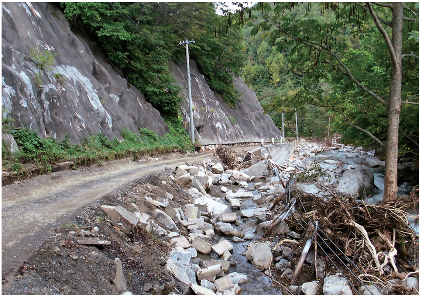
9月21日午後3時52分 応急復旧された道路沿いの河川には被害の爪痕が残っていた
