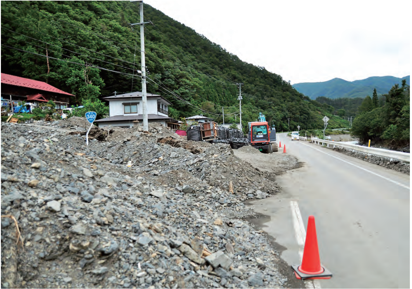
9月19日午後2時43分 国道340号は片側通行になっていた
