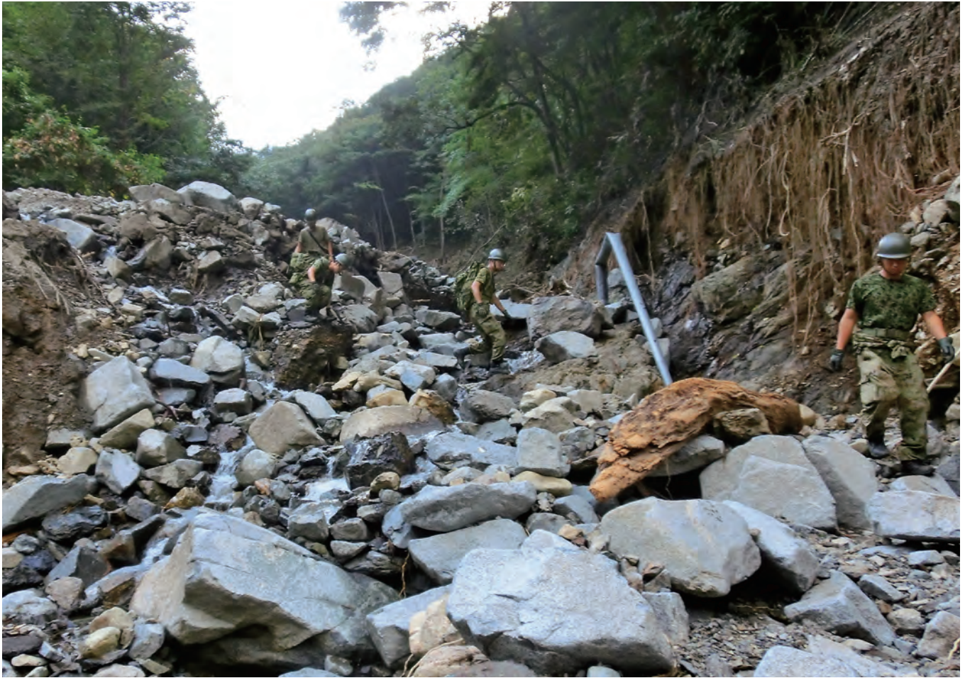
寄部地区は孤立状態になっていた
