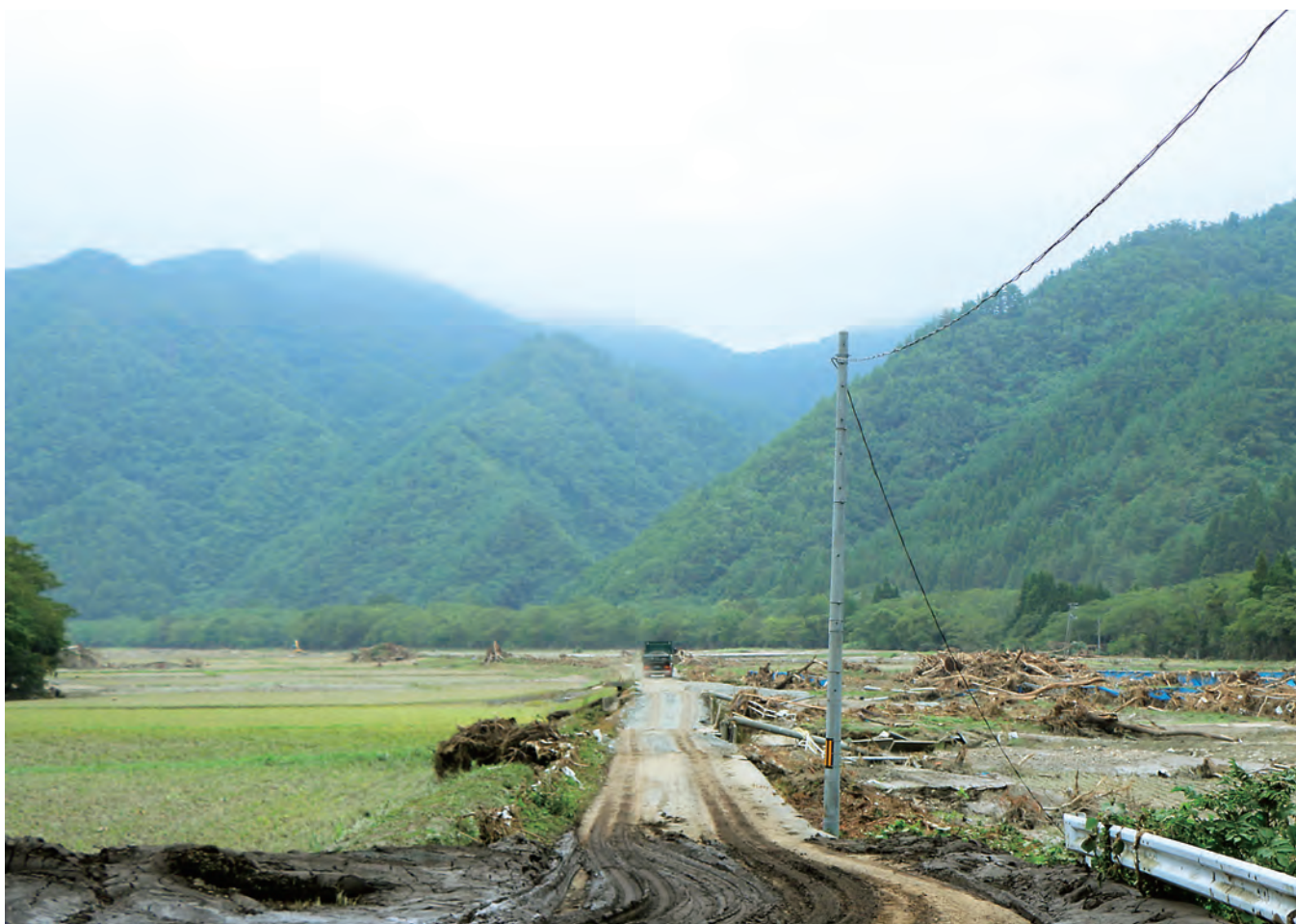
9月3日午後3時48分 震野宮本地区では水田にも大きな被害があった
