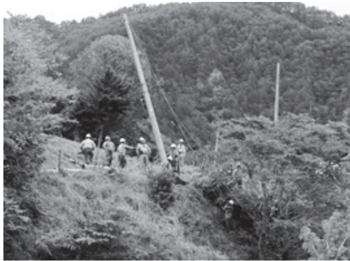
周辺のライフライン復旧に向けた動き (9月4日 13:51)
