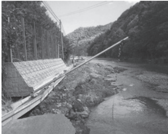
安家川の氾濫で壊れた県道
