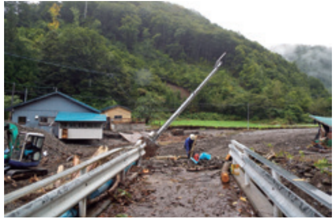
折壁 傾いた携帯基地局
