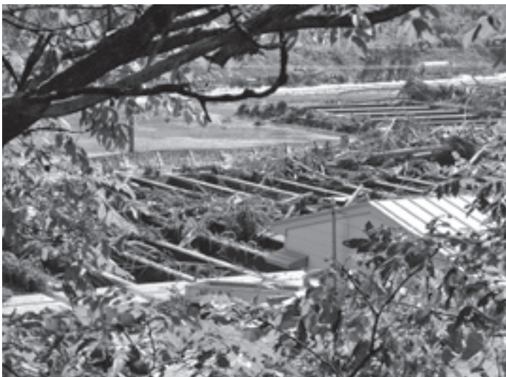
中島・鮭マスふ化場の被害 (8月31日 13:47)
