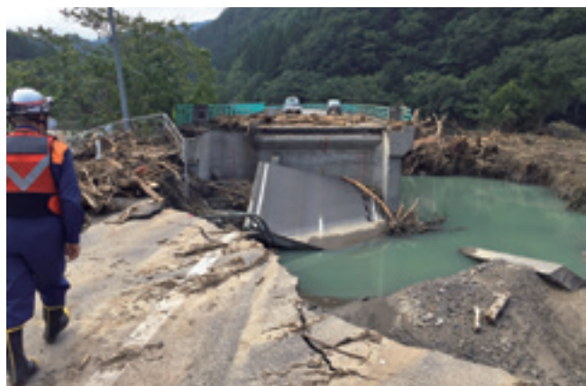
猿沢・有芸と岩泉を結ぶ乙茂橋決壊（9月2日10：27）
