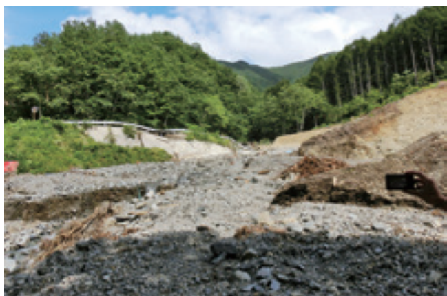
押角峠被災状況 (9月3日 13:12)
