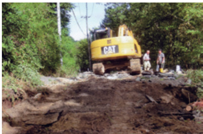
住民による水堀への道路復旧工事（9月4日）※写真提供：佐々木精一
