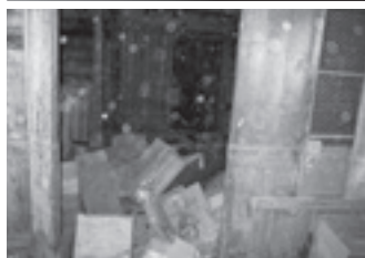
被災した倉庫内部の様子
