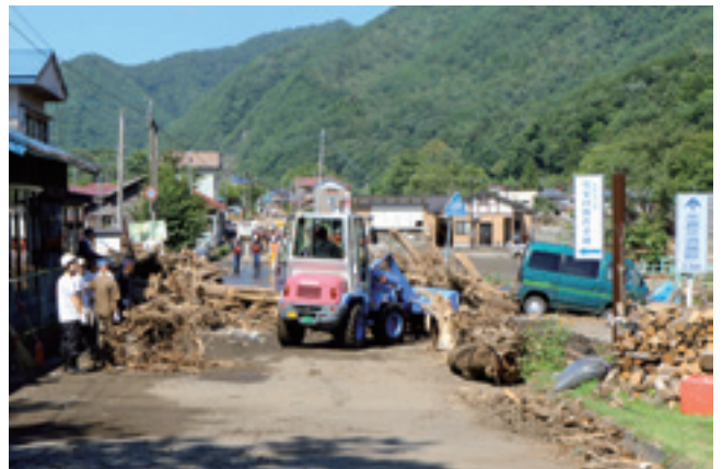
安家 消防団による重機での道路片付け（9月1日 9：47）
