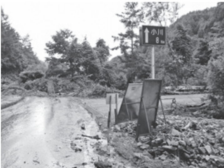
安家から救沢に抜ける奥岩泉線も被害 (9月15日 12:04)
