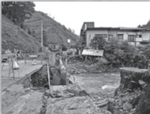
被害を受けた道路・水道施設（見内川地区）
