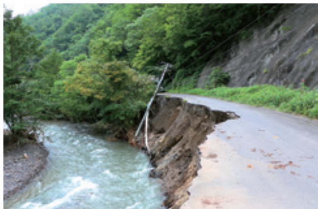
肘葛 道路・電柱被害（9月3日9：50）
