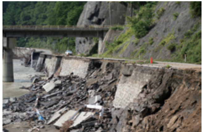
二升石 国道決壊箇所（9月2日14:07）
