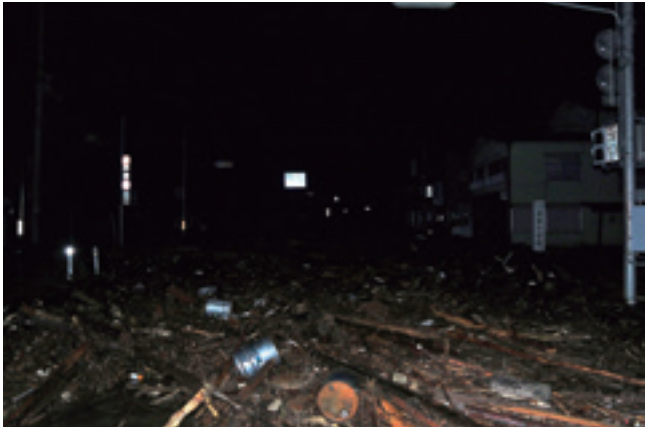
当日夜 岩泉橋前の流木と瓦礫（8月30日21:42）
