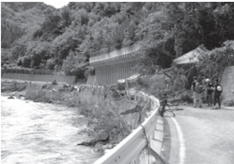
元村～大平間の県道、崩落した擁壁（9月4日 13:18）
