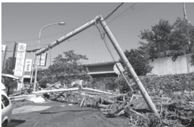
名目入では電柱が折れ曲がっていた（9月1日）
