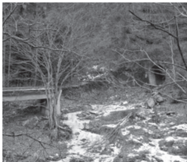
流された岩泉線の橋梁（後日撮影）
