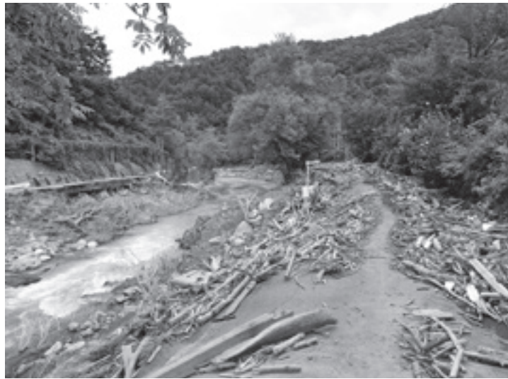
損壊し流木に覆われた周辺の道路 (9月4日 13:49)
