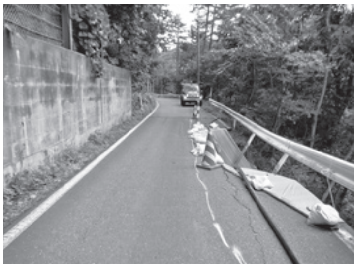
上有芸長者 県道路肩崩壊 (9月15日10:24)
