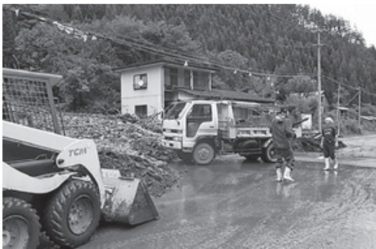
道路に流れ込んだ土砂の片付け（9月14日）
