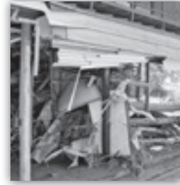
破壊された1階 (9月1日11:25)
