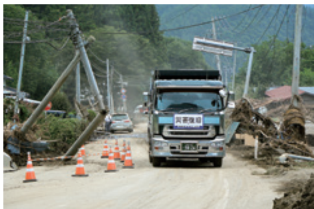
乙茂 道路復旧のため行き交うダンプカー（9月3日15:10）
