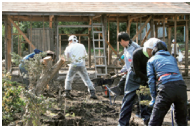
民家庭先の泥出し作業（10月23日11:07）
