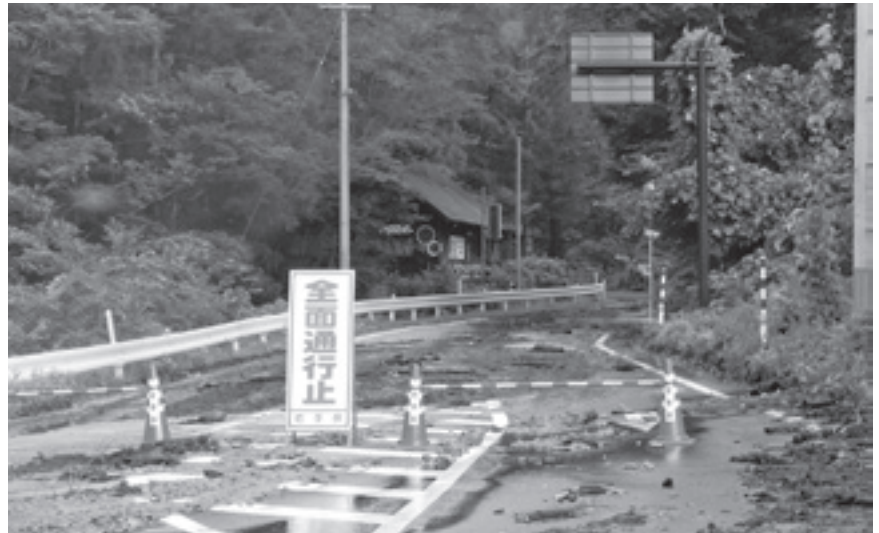
一時通行止めとなった県道7号 (8月31日6:25)
