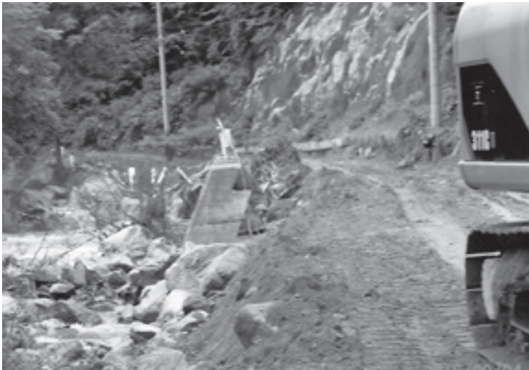
道路復旧工事中 (9月4日) ※写真提供: 佐々木精一
