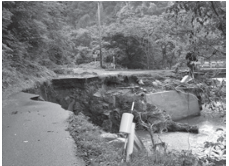
鼠入地区道路決壊状況 (9月3日7:56)
