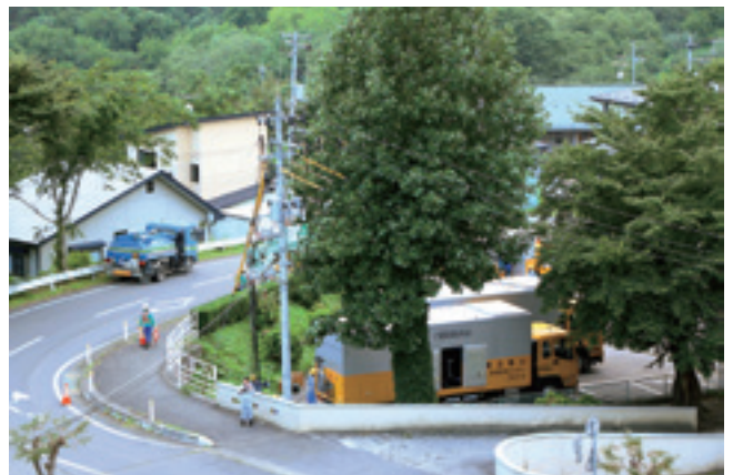
電源車による電気の供給（9月1日 16：58）
