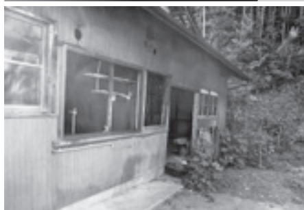
床上浸水の被害を受け解体予定のお宅にて
