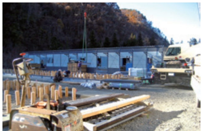
小川・滝の上仮設団地の建設風景 (11月16日)
