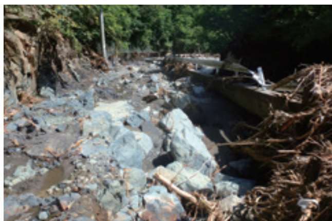
鼠入 破壊された道路（9月3日11:04）
