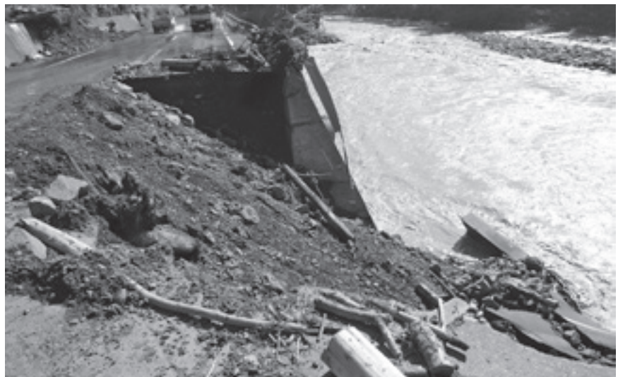
半分流失した国道を行く車（9月1日）
