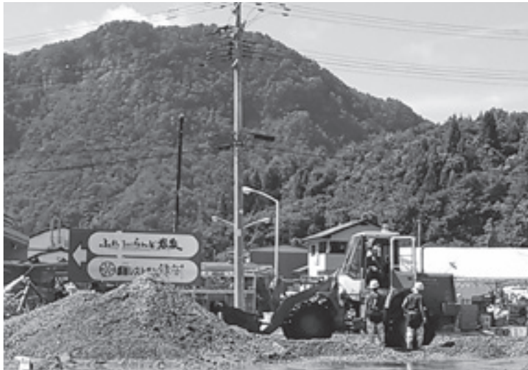
乙茂における道路の土砂撤去の様子（9月5日10:47）
