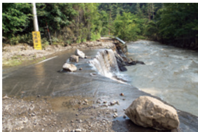
釜津田 県道大川松草線決壊箇所 (9月1日)
