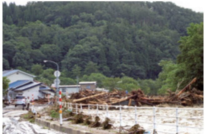
襦綿 田中橋 (8月31日 8:39)
