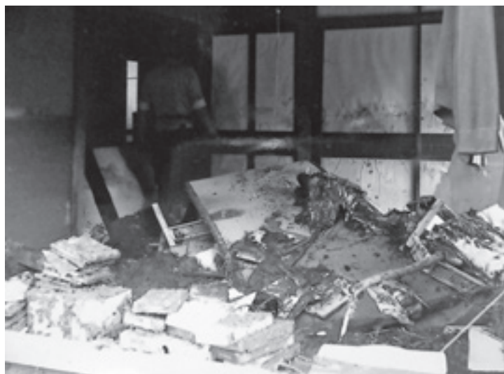
床上浸水した建物の被災状況（8月31日） ※写真提供：川口肇
