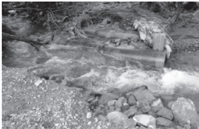
道路のヒューム管がむき出しに、農家に車が入りできず (9月2日) ※写真提供：佐々木精一
