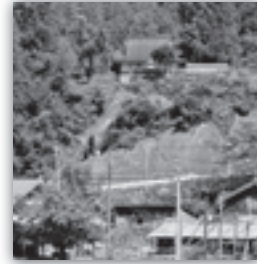
安家寺前の土砂崩れ (9月1日9:52)
