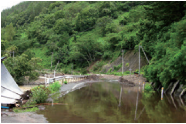
三田貝 国道455号冠水 (8月31日 10:19)
