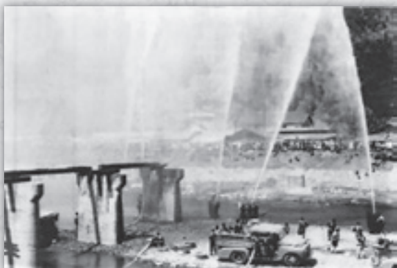
アイオン台風で落橋した小本橋のそばで行われる町村合併大水防演習 岩手県漁港史より
