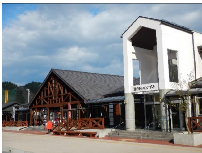
平成 28 年台風第 10 号災害から復旧した道の駅
