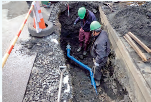
水道管工事の様子
