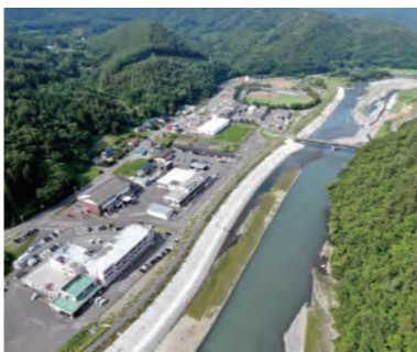
河川改修工事が進む小本川
