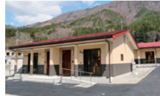
4 月に完成した上町災害公営住宅
