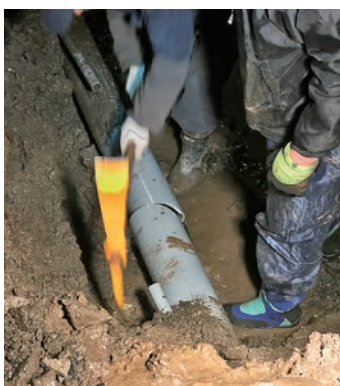
漏水の修理をする指定業者
