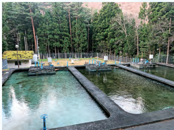
③ ろ過池 ごみや砂を沈めたり、水をこしてきれいにします
