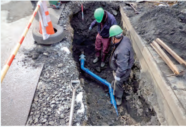
水道管工事の様子
