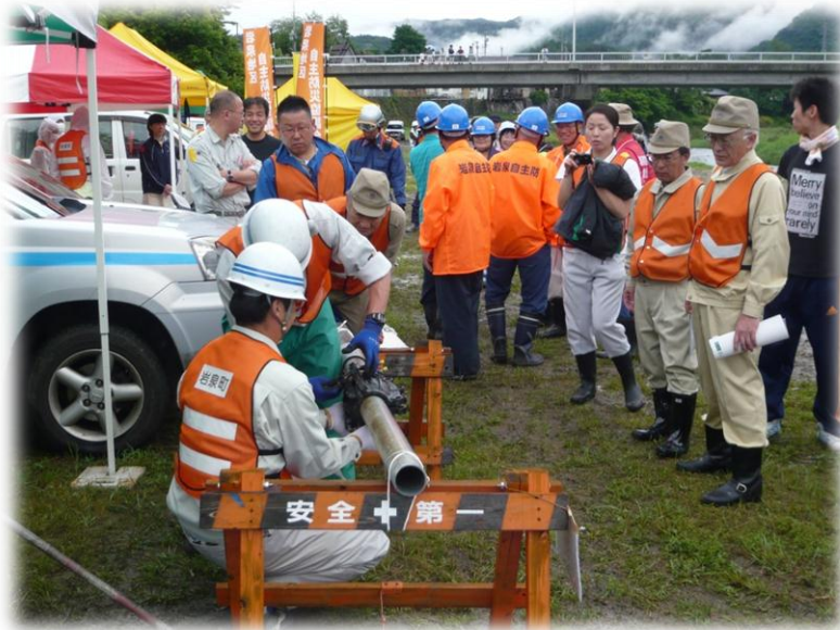
防災訓練での応急漏水修理訓練の様子
