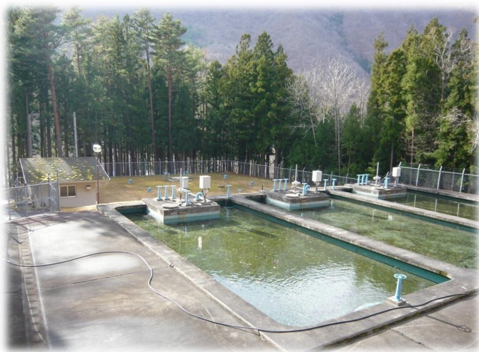
岩泉簡易水道浄水場
