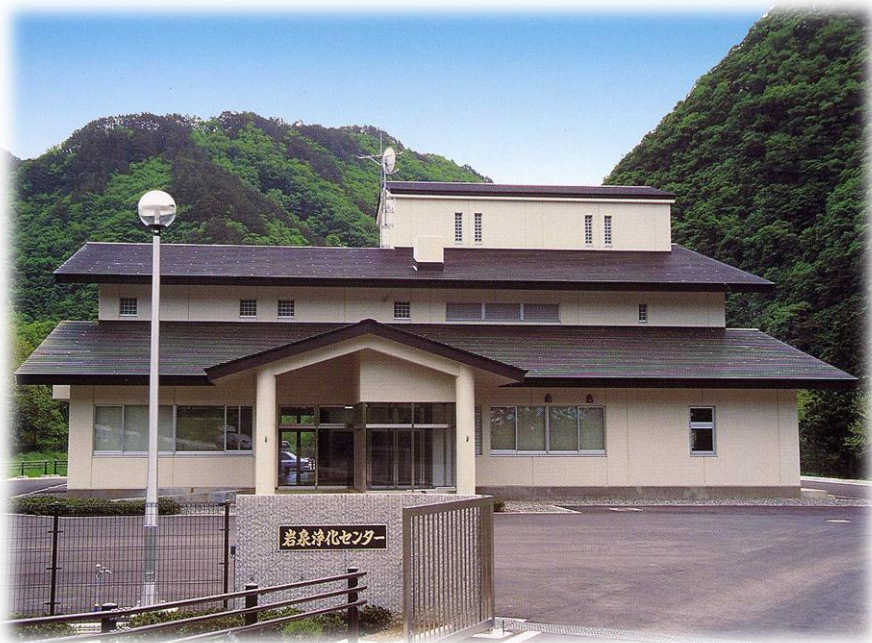
岩泉浄化センター（公共下水道施設）
