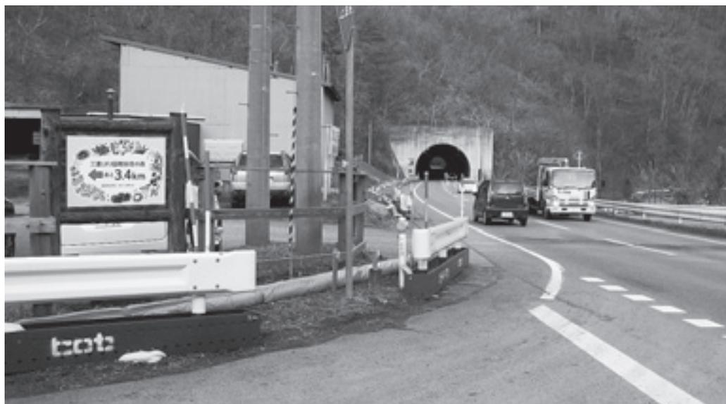
松橋地区のむき出しの水道管（町水道の本復旧が待たれます）
