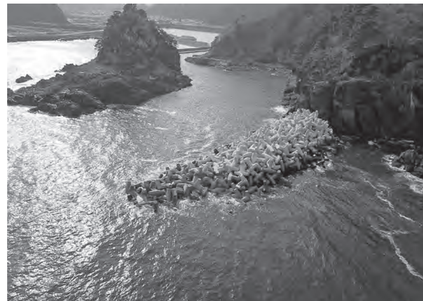
平成20年から改良工事が進められている北防波堤
