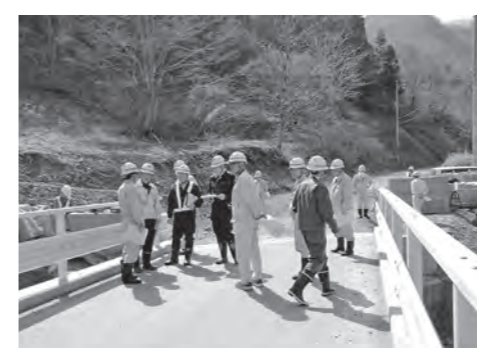
町道鼠入川線の現場調査（31年4月）
