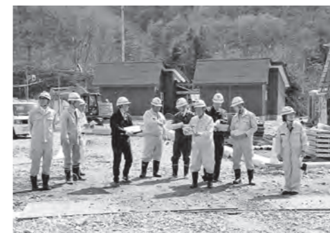
安家地区の住宅再建現場調査（31年4月）
