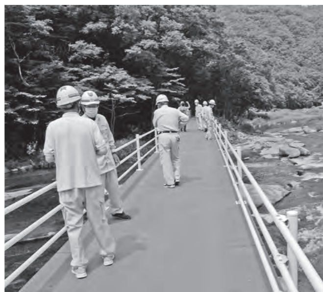
生活橋補助事業完了現場
